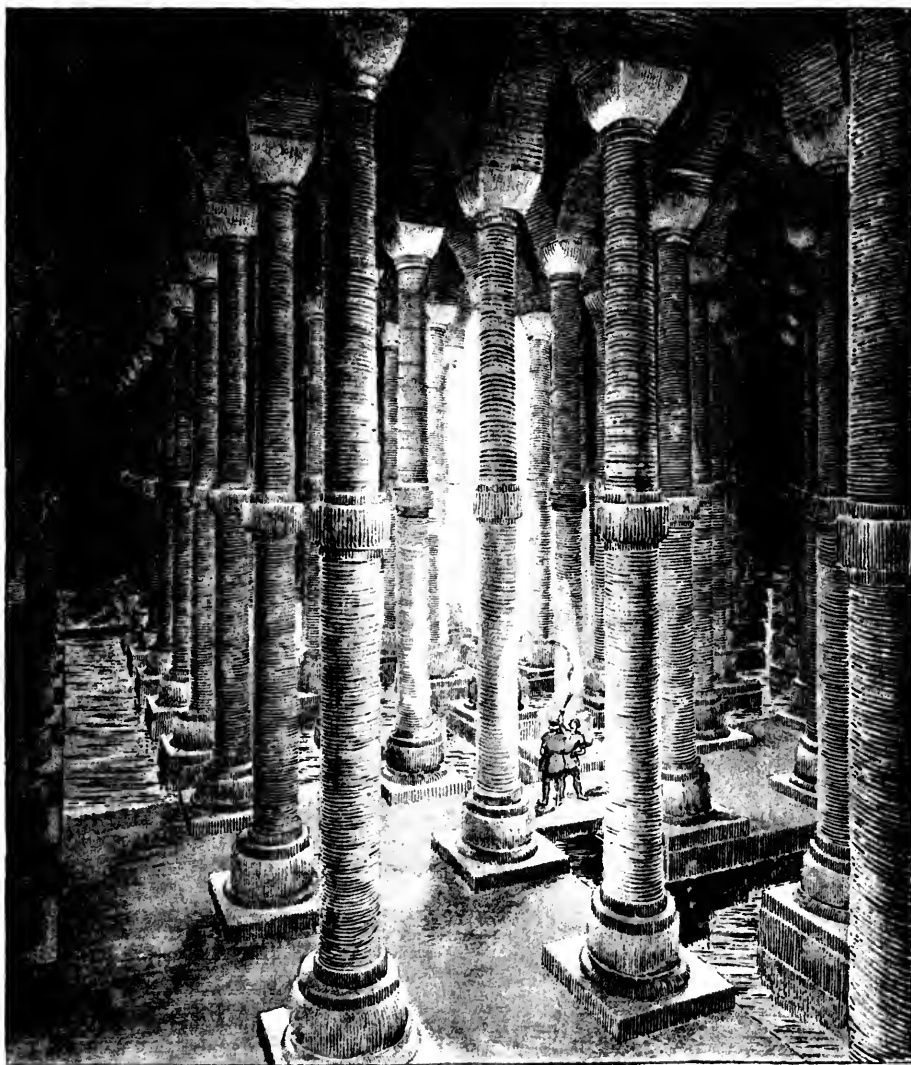
CISTERNE BIN BIR DIREK REKONSTRUKTION
